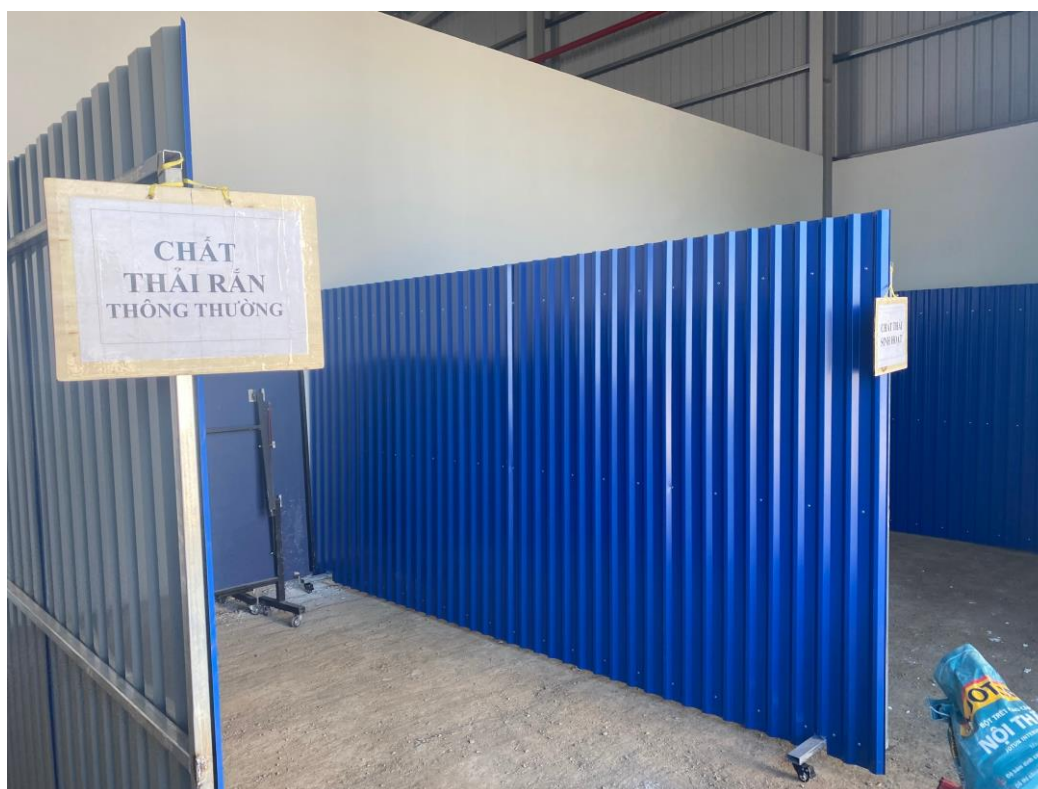
Hình 3.10. Kho chứa chất thải rắn công nghiệp thông thường
