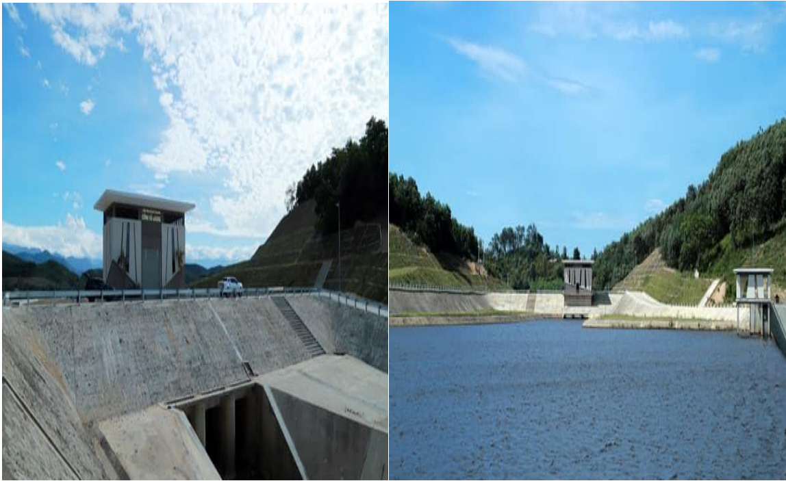
Hình 1. 22. Công trình đầu mối cống Vũ Quang - nơi điều tiết nước từ đập dâng Vũ Quang chạy về hệ thống kênh Ngàn Trươi để nhập vào hệ thống kênh Linh Cảm
