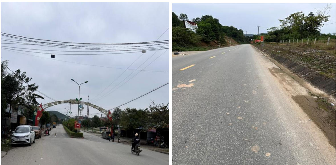
Hình 1. 14 Đường ĐT552 (Tỉnh lộ 5)
