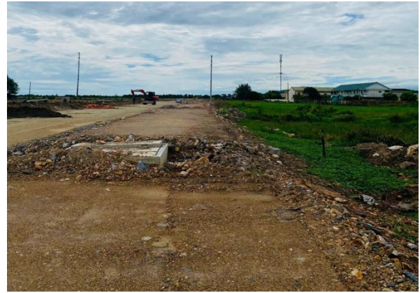
Hình 1.5: Đường đang thi công phía Bắc Dự án
