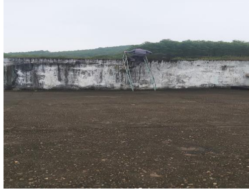
Công trình cấp nước sinh hoạt xã Kỳ Hoa– Thị xã Kỳ Anh
