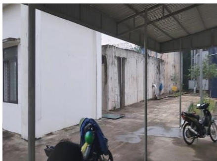
Công trình cấp nước sinh hoạt xã Cẩm Thạch – huyện Cẩm Xuyên
