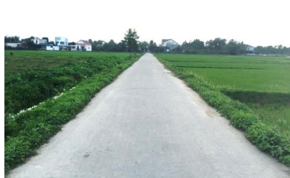
Hình 1.5: Đường bê tông phía Bắc Dự án
