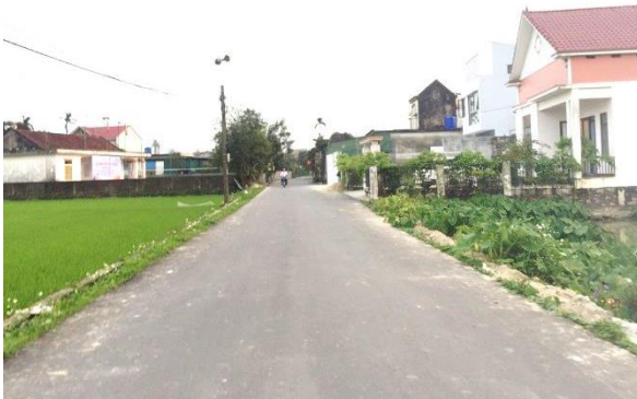
Hình 1.4: Đường nhựa hiện trạng phía Tây Dự án
