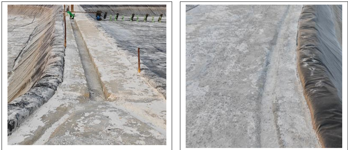
Hình 3.1: Mương thu gom, thoát nước mưa đường nội bộ trong khu nuôi
