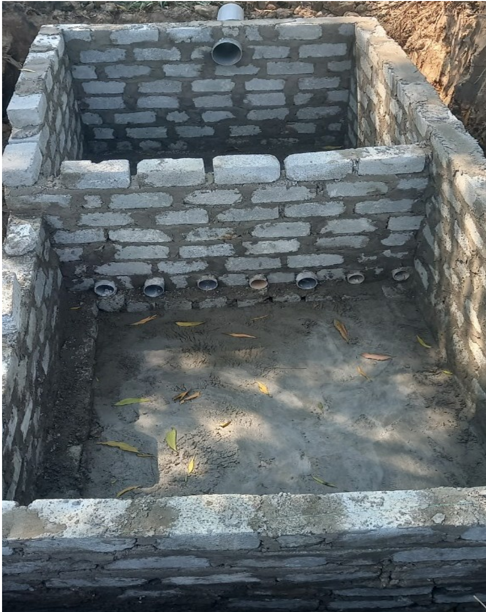
Hình 3.9. Hình ảnh thi công bể lọc và bể khử trùng tại cơ sở
