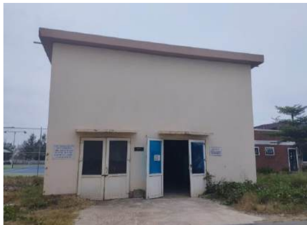
Trạm biến áp của Villa biển
