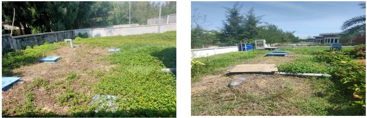
Hình 3. 4. Các trạm xử lý nước thải tập trung
