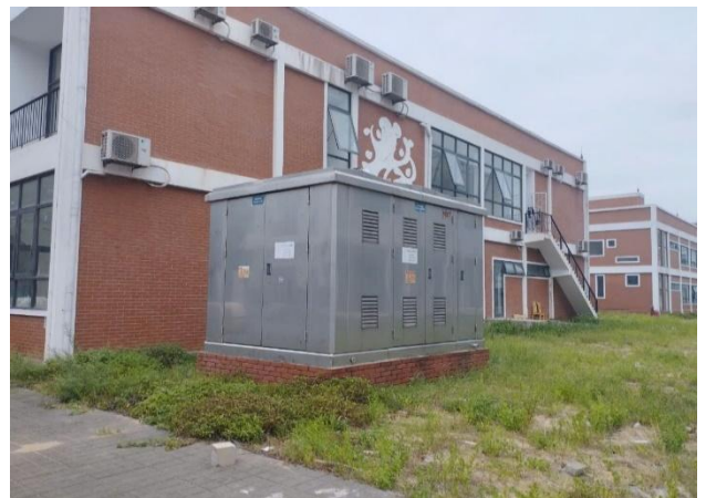
Trạm biến áp khu vực TTTM, nhà giữ trẻ, trạm y tế
