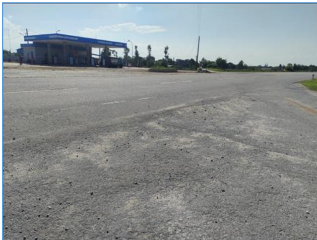
Đoạn đầu tuyến
