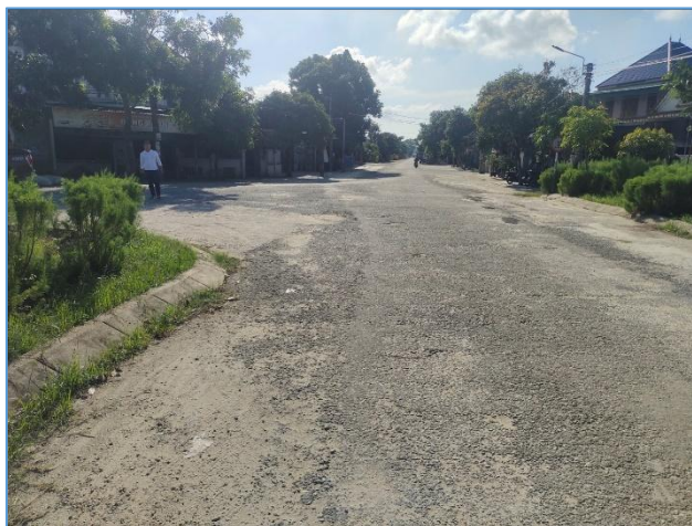
Đoạn cuối tuyến
