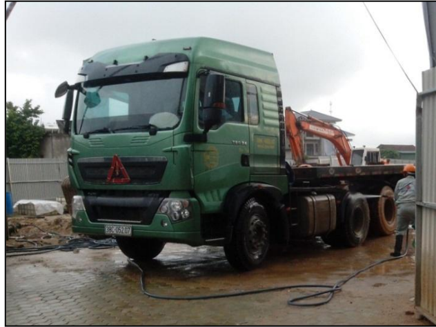
Hình 3.14. Rửa xe trên công trường thi công
