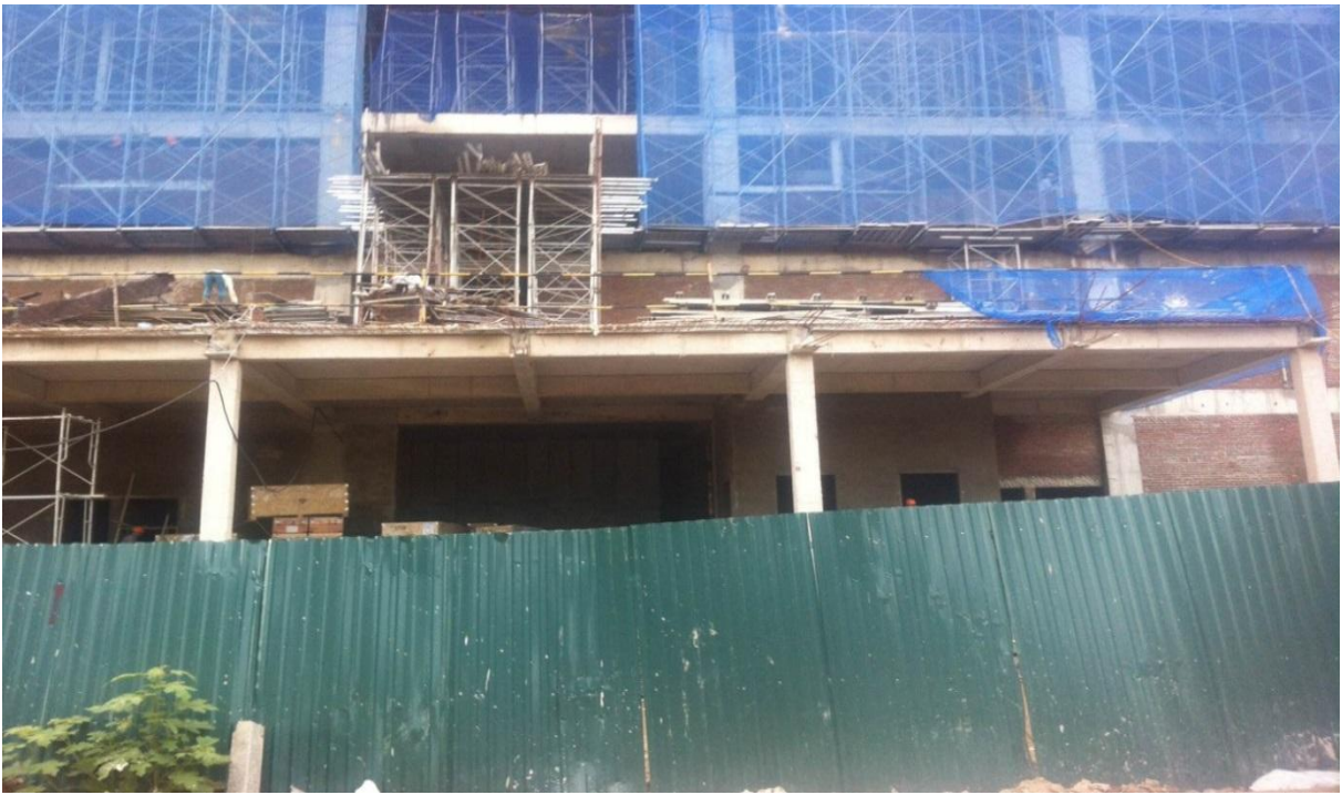
Hình 3.15. Hình ảnh tường bao bằng tôn và lưới chắn bụi công trình cao tầng.
