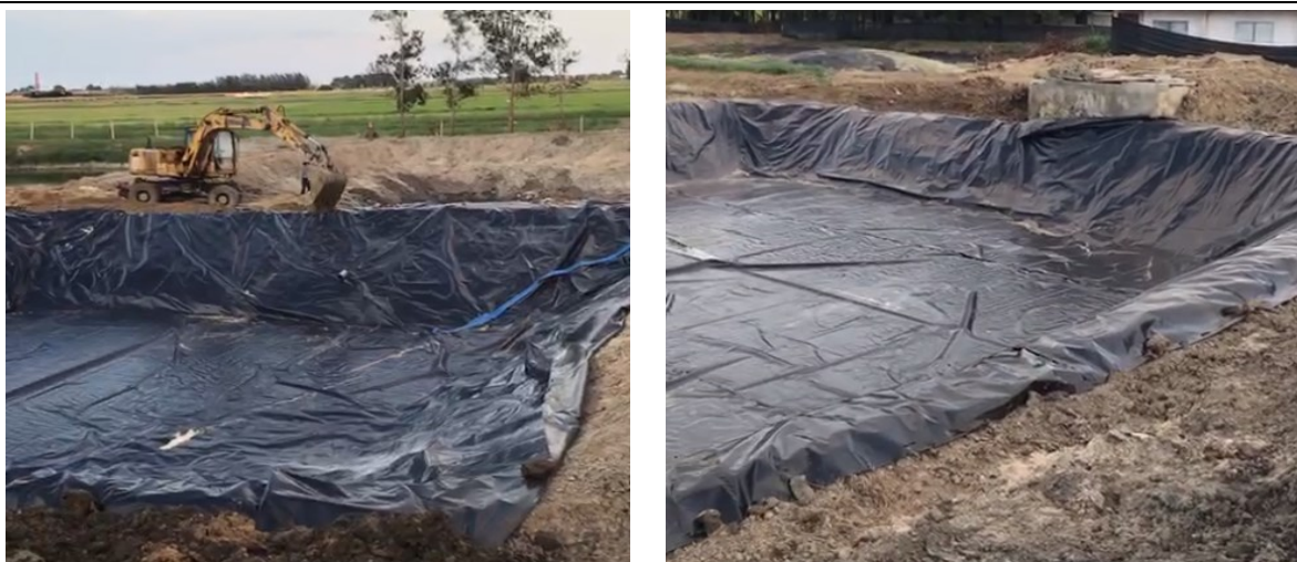
Hình 3.11. Hình ảnh thi công cải tạo công trình BVMT tại Cơ sở Bảng 3.4. Tổng hợp các thông tin các công trình xử lý nước thải của trang trại:
