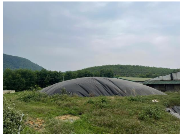
Hình 3.5. Hố lắng phân và bể biogas đã xây dựng tại Trang trại
