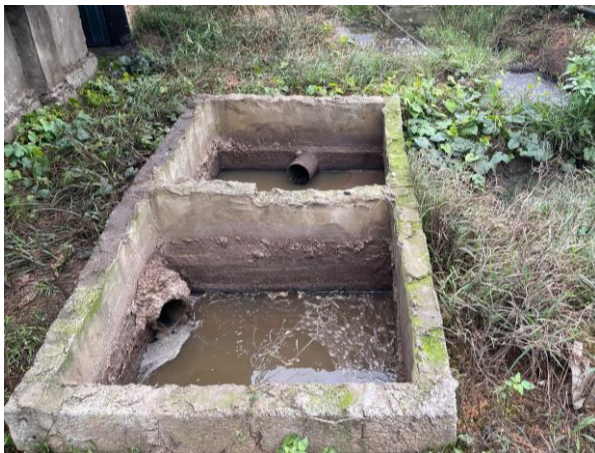
Hình 3.5. Hố lắng phân và bể biogas đã xây dựng tại Trang trại
