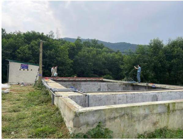
Hình 3.7. Hệ thống xử lý nước thải đã xây dựng tại Trang trại
