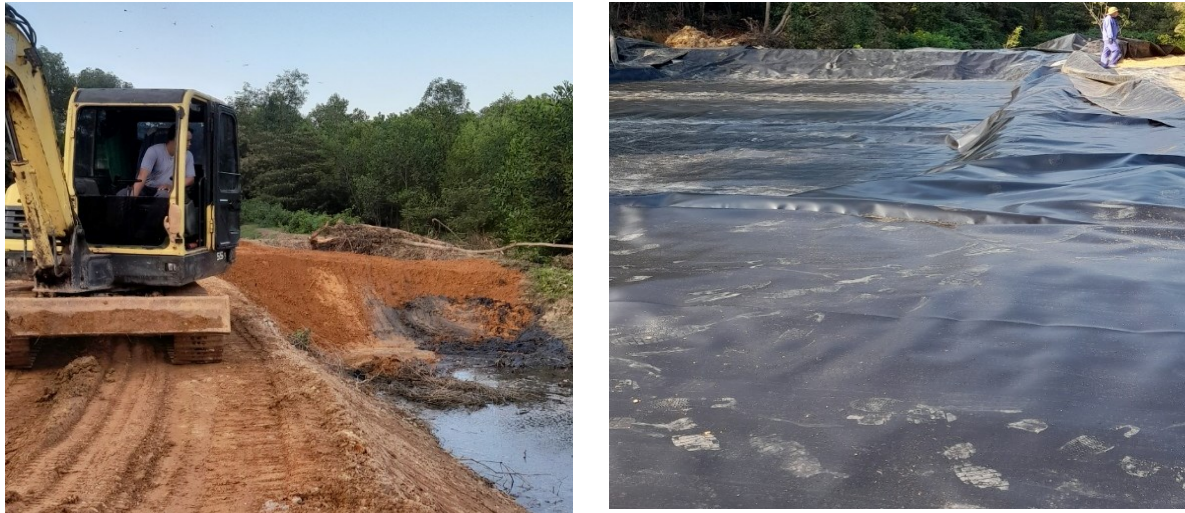
Hình 3.10. Hình ảnh thi công cải tạo công trình BVMT tại Cơ sở
