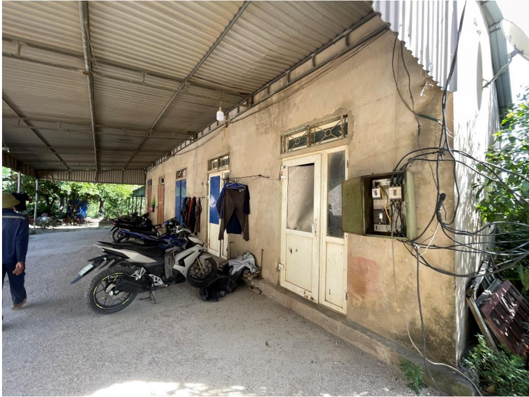
Hình 1. 3. Khu nhà nghỉ công nhân
