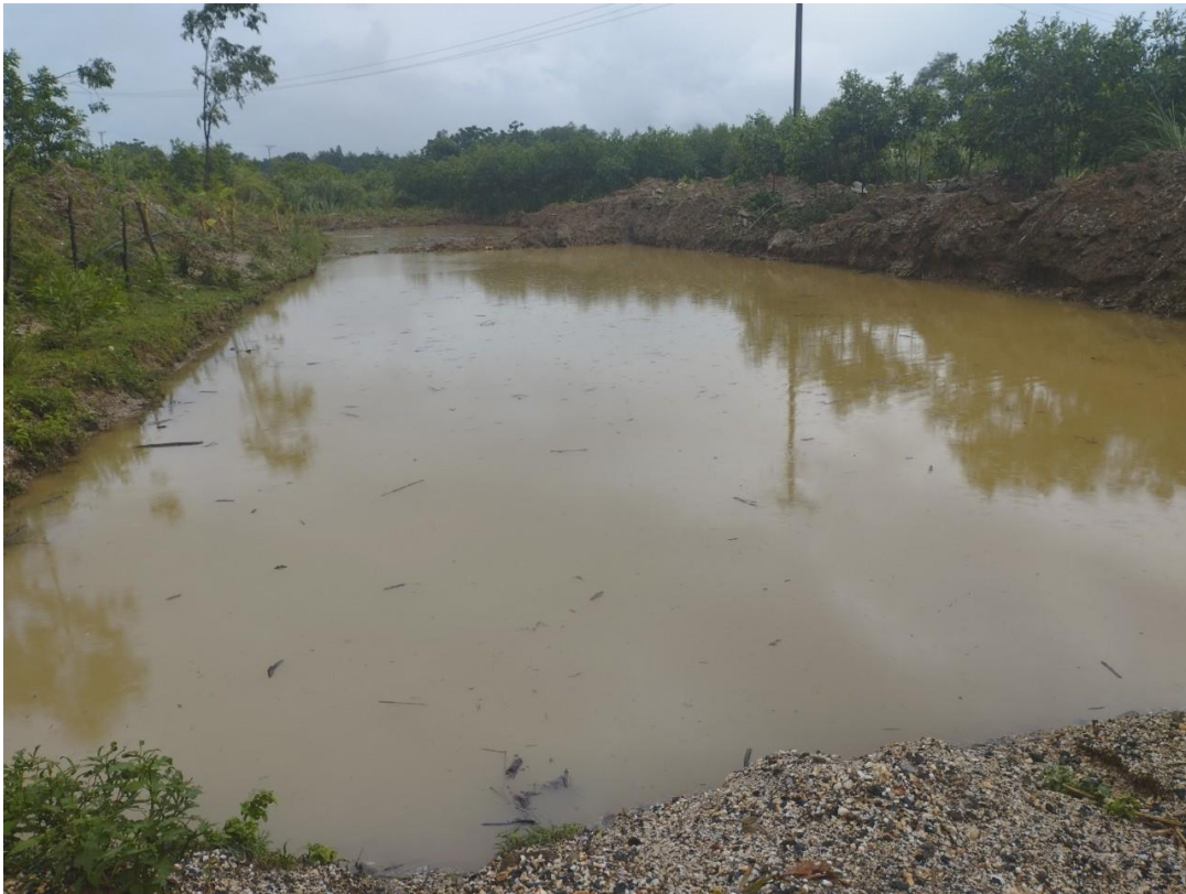
Hình 3. 6. Hồ lắng nước mưa chảy tràn tại mỏ
