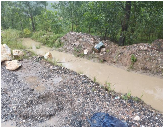
Hình 3. 2. Mương thu gom nước mưa chảy tràn
